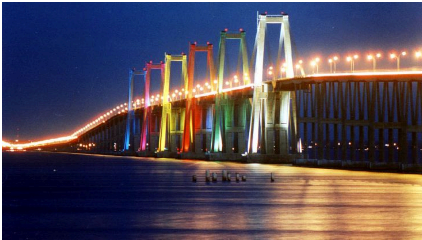
Puente “General Rafael Urdaneta” sobre el Lago de Maracaibo
